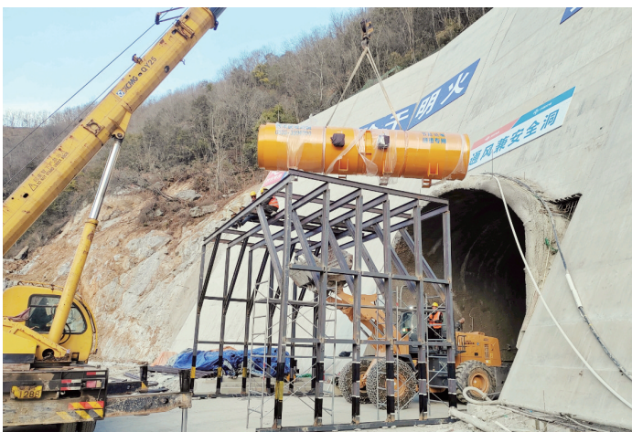
佛坪抽水蓄能项目建设施工现场。
