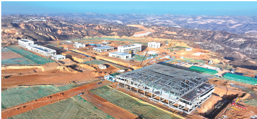
正在建设的府谷府州机场。朱鑫 摄
