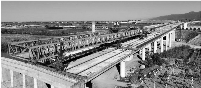
大桥实现全幅贯通。
