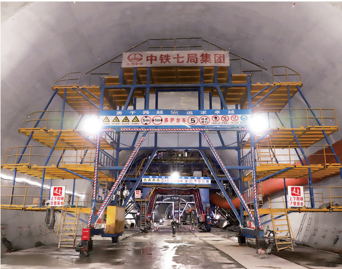
西康高铁秦岭九天山隧道施工现场。 本报记者 马昭 摄
