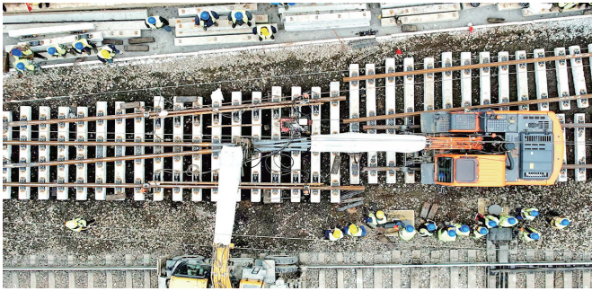
道岔更换施工现场。
