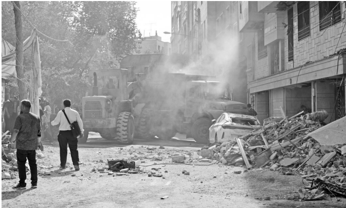
6月13日,在伊朗首都德黑兰,工程车辆清理在以军袭击中受损的建筑。
