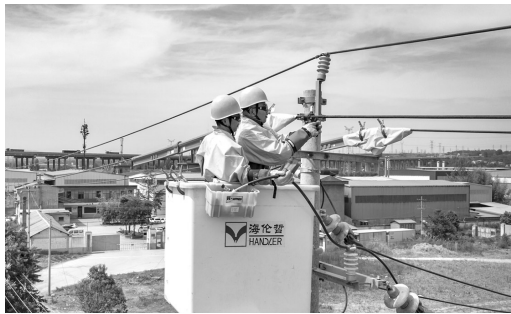
电力人员高空带电作业。
