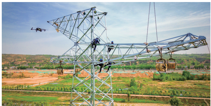
无人机助力线路改造,保障电网迎峰度夏。
