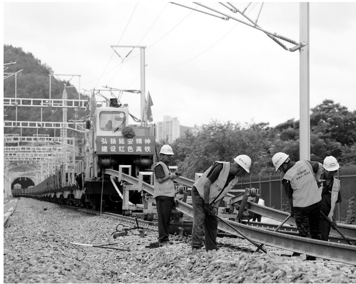
施工人员正在铺设最后一对长钢轨。 姬文彬 摄
