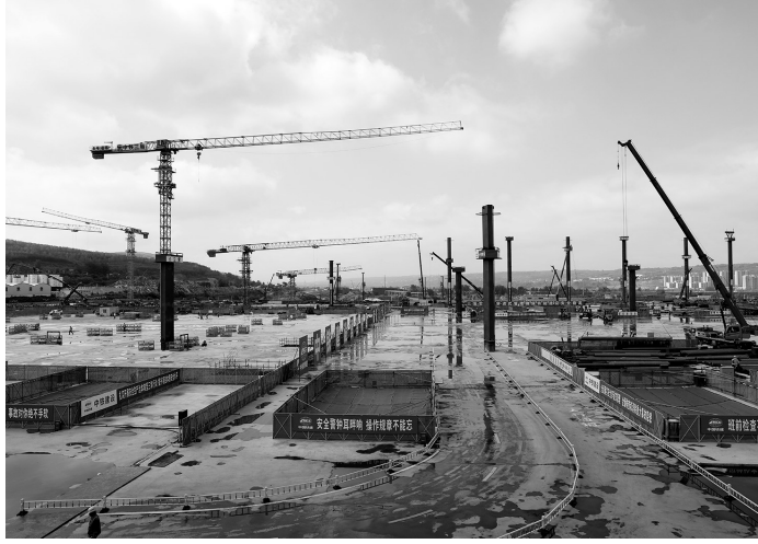
西安东车站房主体混凝土结构封顶。 赵胜利 摄
