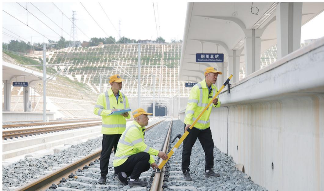
工人正在对铜川北站站台限界尺寸进行测量。贾智炜摄
