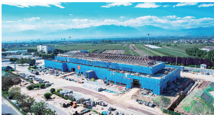
眉县服务区提质升级项目推进顺利。
