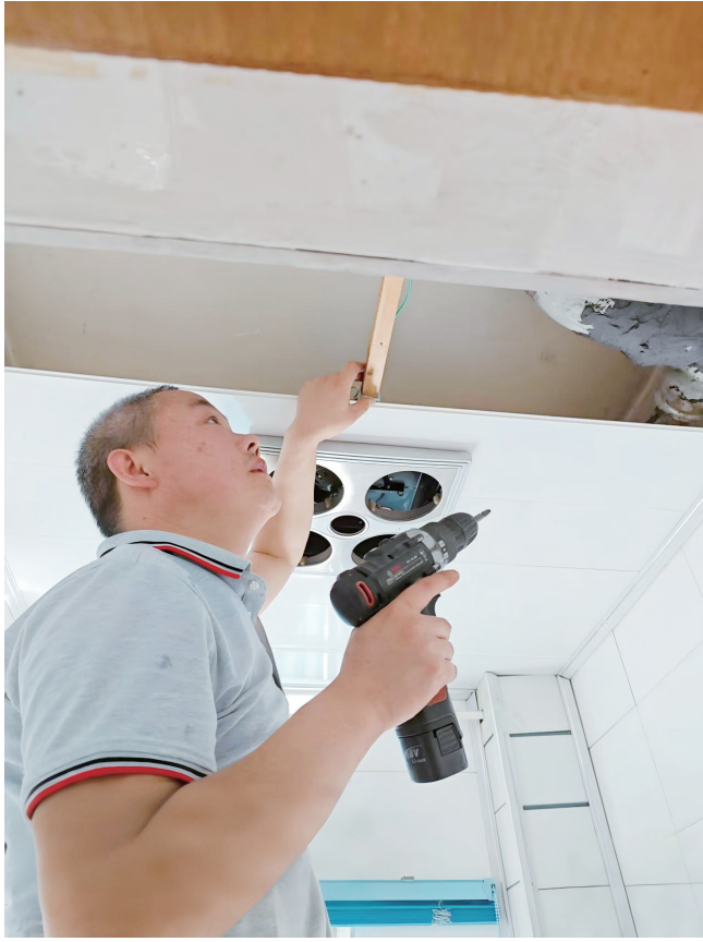
“社区+物业”应急服务队上门检查居民家中漏水情况。(受访者供图)
