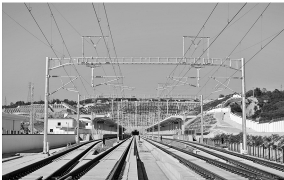
9月4日,西延高铁全线接触网实现贯通。
