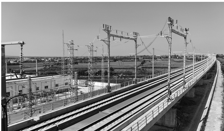
西延高铁全线接触网送电成功。赵春梅 摄
