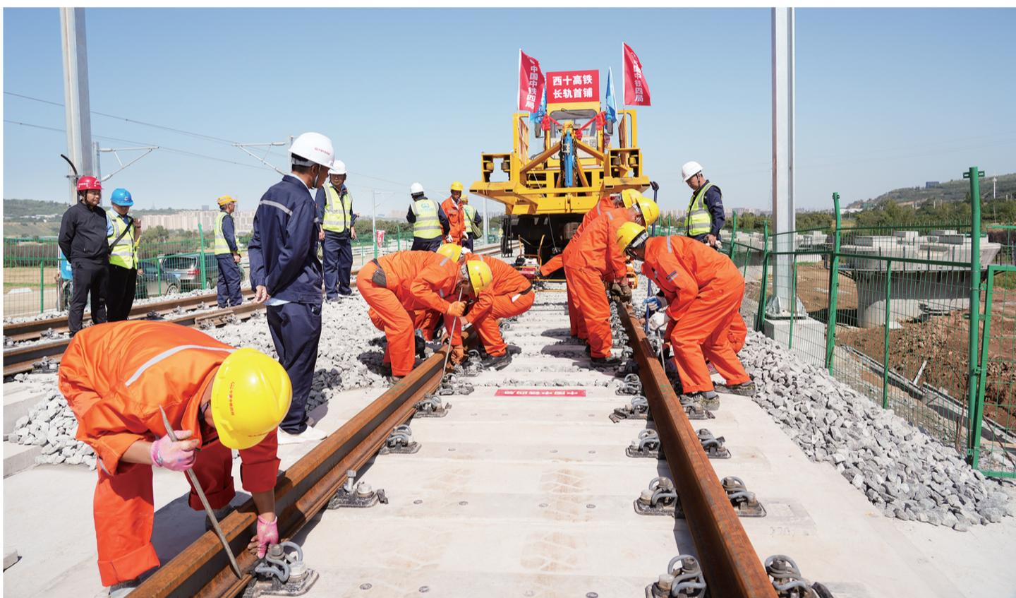
9月8日,在西十高铁建设现场西安东至蓝田作业区间,施工人员将首对500米长的无缝钢轨平稳铺设在无砟轨道板上,标志着由西成客专陕西公司建设、中铁四局施工的西十高铁全线铺轨正式启动。图为施工现场。
