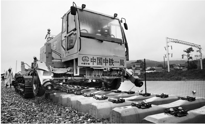
10月11日,中铁一局施工人员操作自主研发新型多功能长钢轨牵引车在西康高铁西安东站至牛背梁站区间铺设无缝钢轨。 新华社记者 李一博 摄
