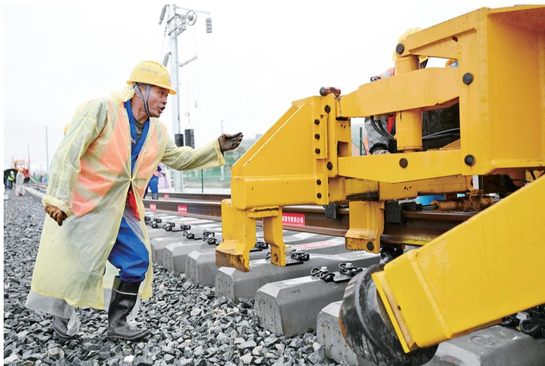
10月11日,在西康高铁建设现场西安东站至牛背梁站区间,施工人员将首对500米长的无缝钢轨平稳铺设在无砟轨道板上,标志着由西成客专陕西公司建设、中铁一局施工的西康高铁全线铺轨正式启动。图为施工人员在西康高铁西安东站至牛背梁站区间铺轨现场作业。 新华社记者 李一博 摄
