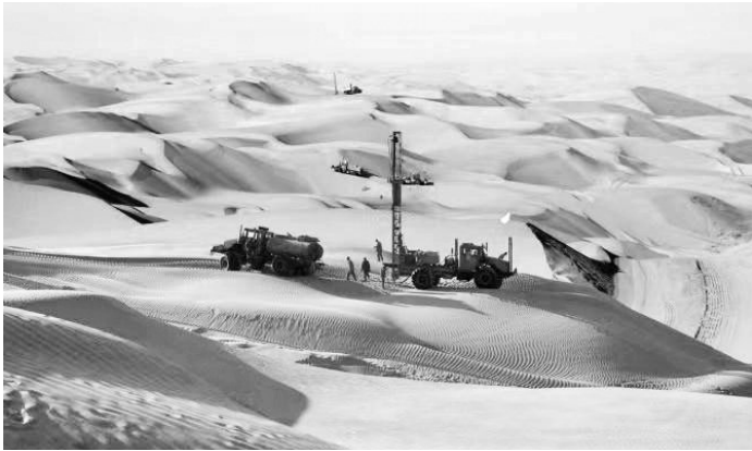
项目作业现场。
