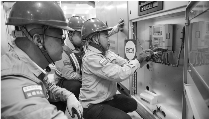
国网安康市高新区供电公司员工在海玺·外滩小区配电室内安装正式电源计量。
