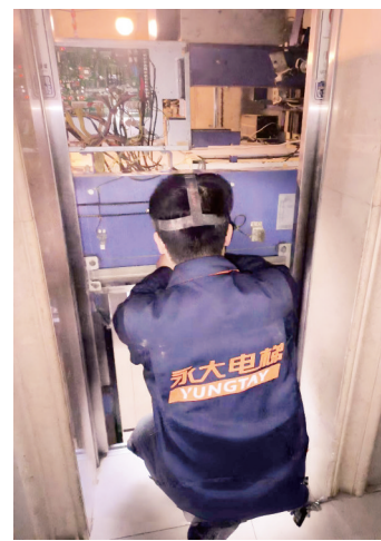
工作人员维修小区故障电梯。
