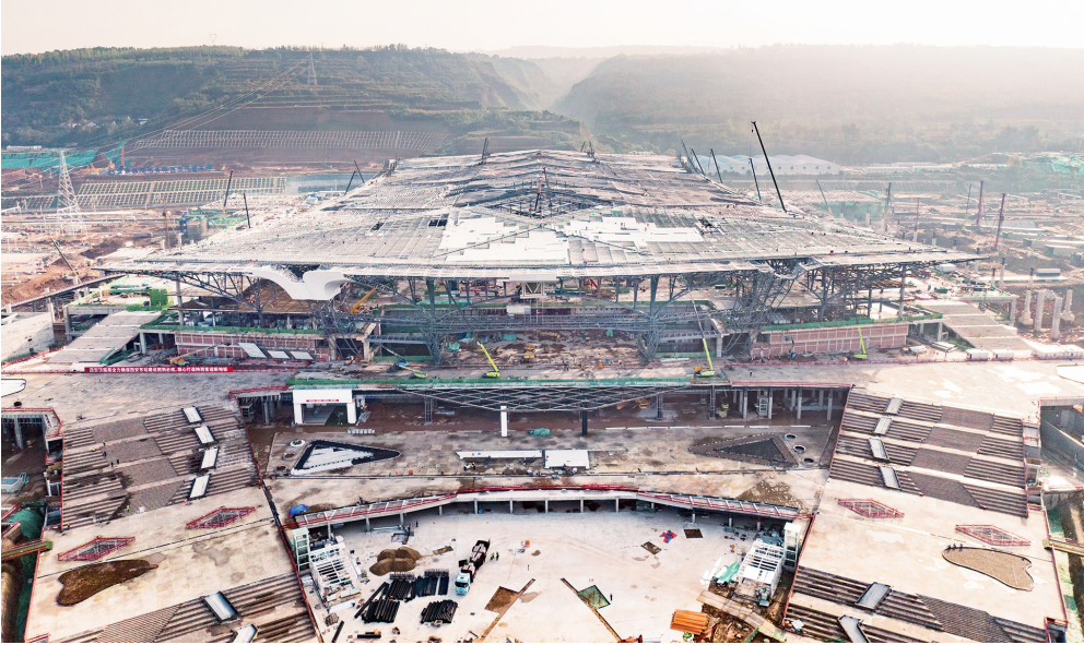
10月27日拍摄的特大型铁路综合交通枢纽西安东站建设现场(无人机照片)。新华社发(刘翔 摄)
