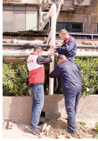
社区协调更换小区水管
