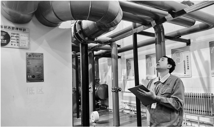
暖数据。工作人员在一小区热交换站记录供
