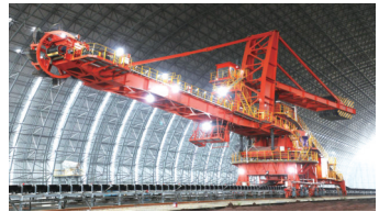
陕钢集团龙钢公司机械化一次料场内景。
