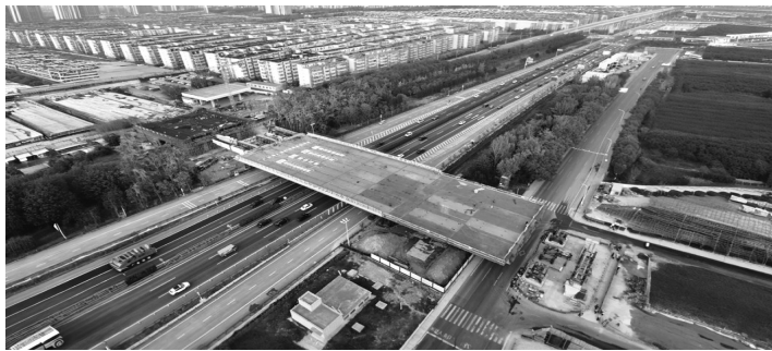
西安广运潭大道跨绕城高速项目完成钢箱梁顶推施工。
